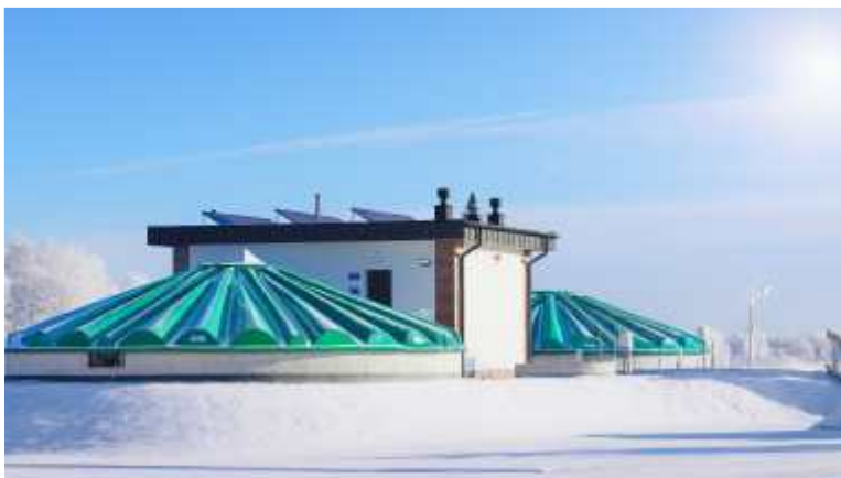
Oczyszczalnia ścieków w Kamieńcu
